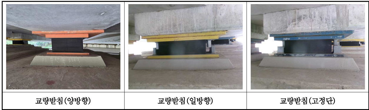
【사진 8.3.13】 교량반침 전경
