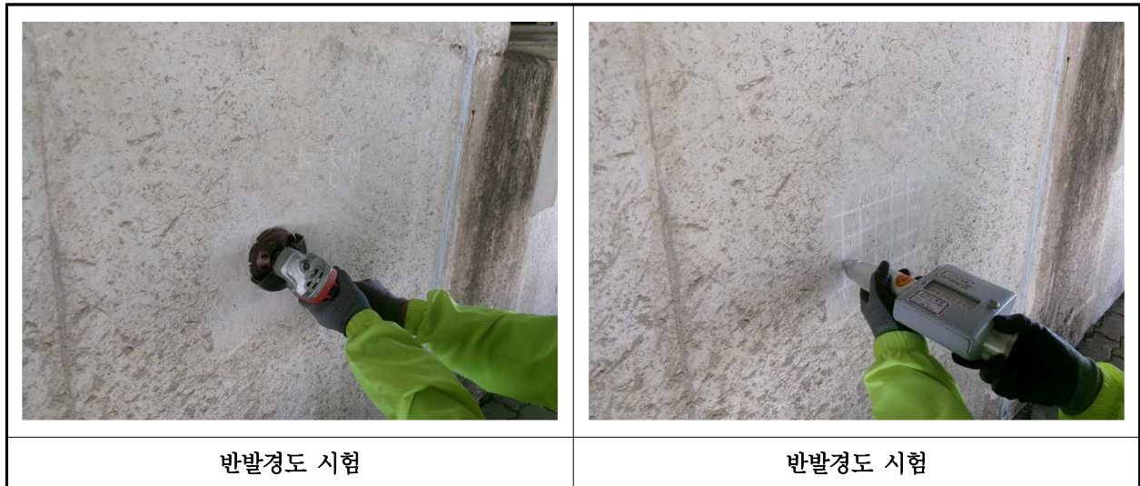
【사진 8.4.2】 반발경도시험 현장사진
