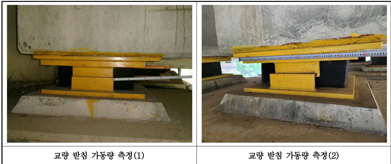
【사진 8.3.16】 교량받침 이동량 측정
