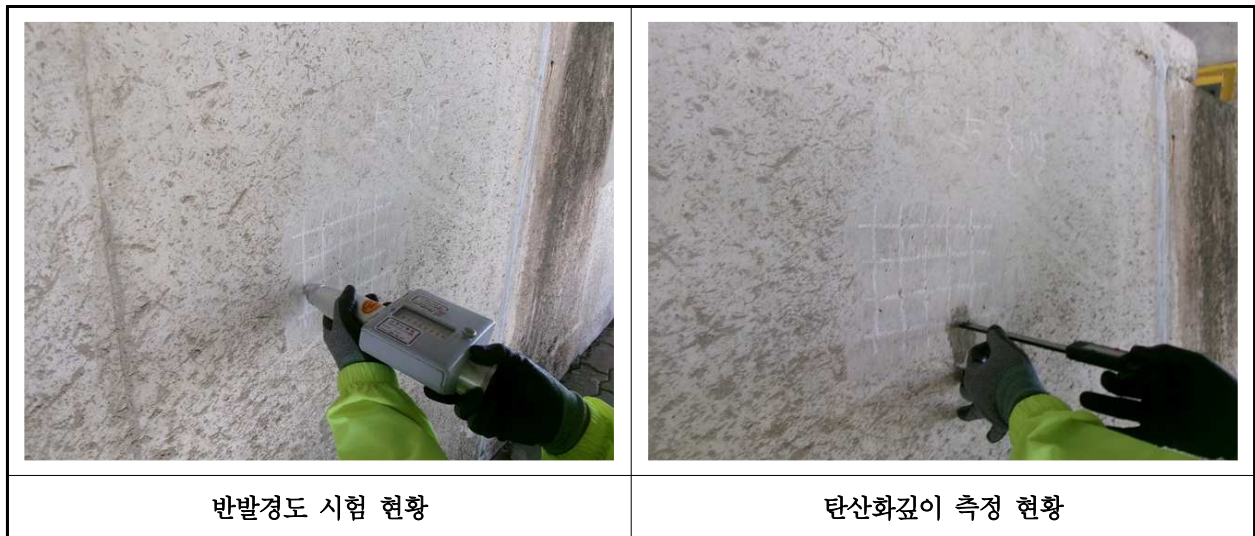
【사진 8.4.1】 콘크리트 내구성조사 현황
