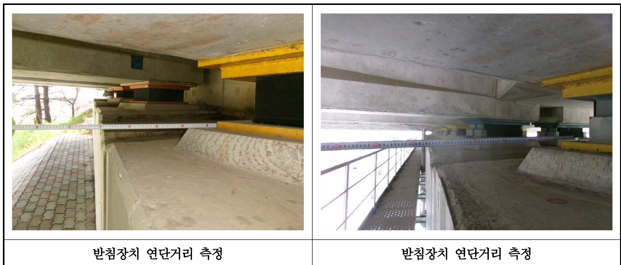
【사진 8.3.15】 교량받침장치 연단거리측정
