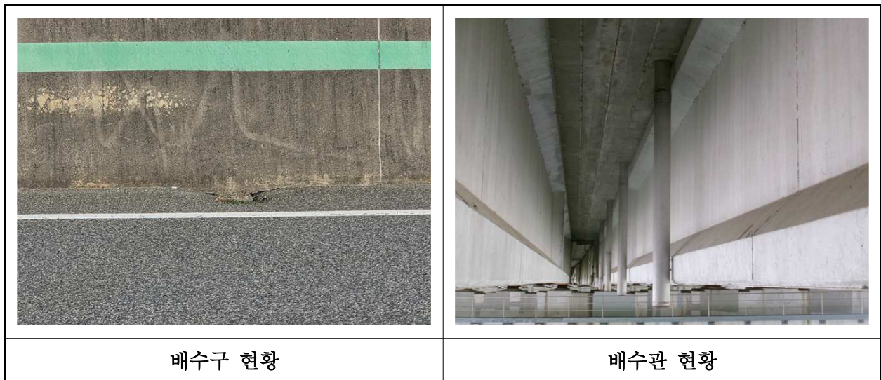
【사진 8.3.22】 배수시설 전경
