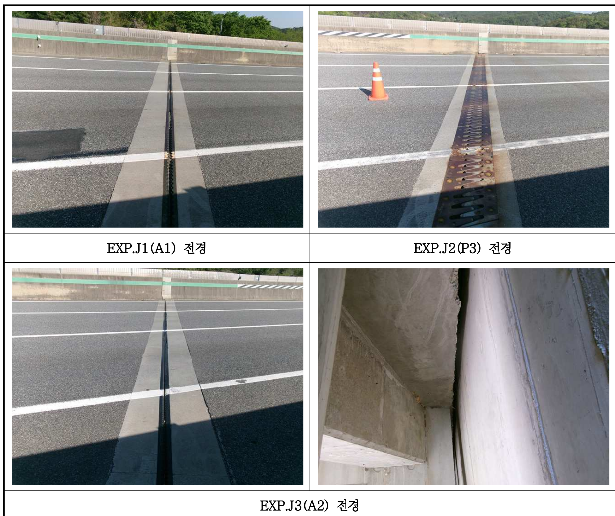
【사진 8.3.17】 신축이음장치 전경
