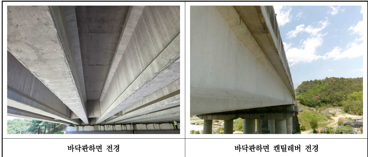
【사진 8.3.2】 바닥판하면 전경
