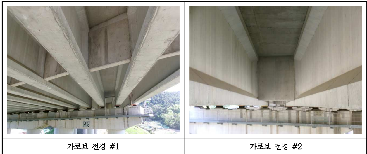
【사진 8.3.6】 가로보 전경
