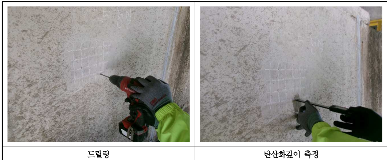
【사진 8.4.3】 탄산화 깊이 측정 현장사진
