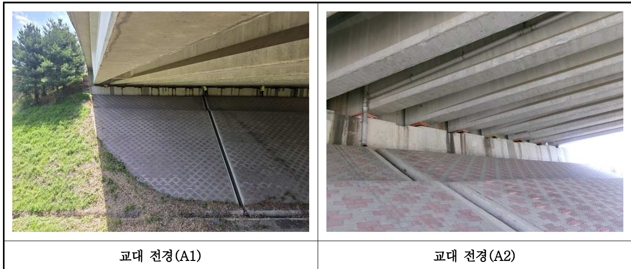
【사진 8.3.8】 교대 전경
