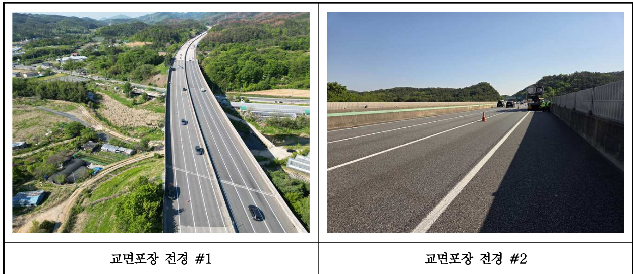
【사진 8.3.20】 교면포장 전경
